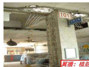
翼牆：植筋清孔
