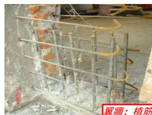
翼牆：植筋鑽孔
