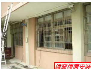
鐵窗復原安裝
