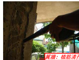
翼牆：植筋鑽孔
